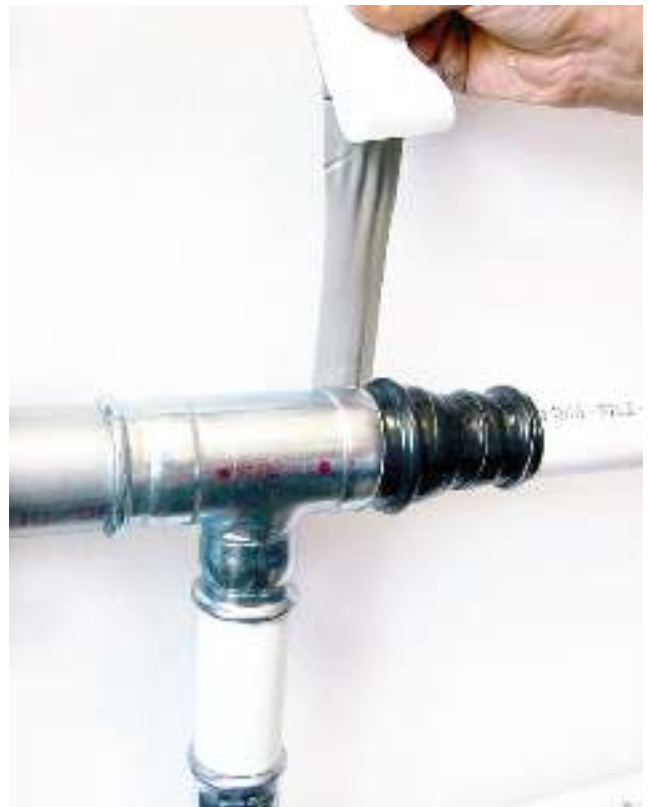
Рис. 38. Защита соединений с помощью бутаноловой клейкой ленты.
