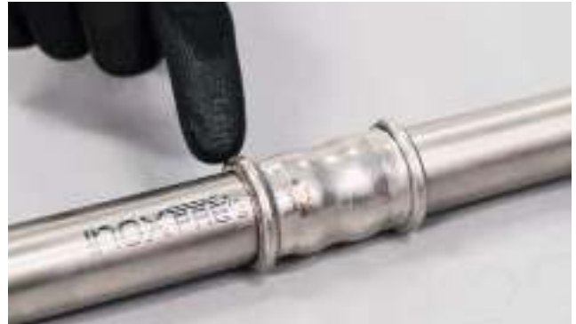
Рис. 33. Проверка пресс-соединения.
